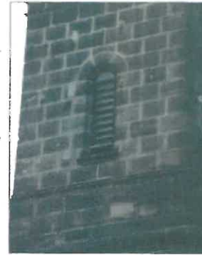
(11) Lamellenverkleidung im Fenster der Turmruine der ehemaligen Hammer Eisenbahnbrücke.
